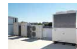
2012 Nuove unità GHP. I sistemi VRF a gas di Panasonic sono ideali per progetti in cui è necessario rispettare limitazioni energetiche.
